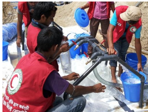
Bangladesh の洪水災害で出動したキット。写真左は浄水装置、1 時間に最大 4,000 リットルの浄水が可能。 簡易水道 (写真右) を接続して供給 ©IFRC
